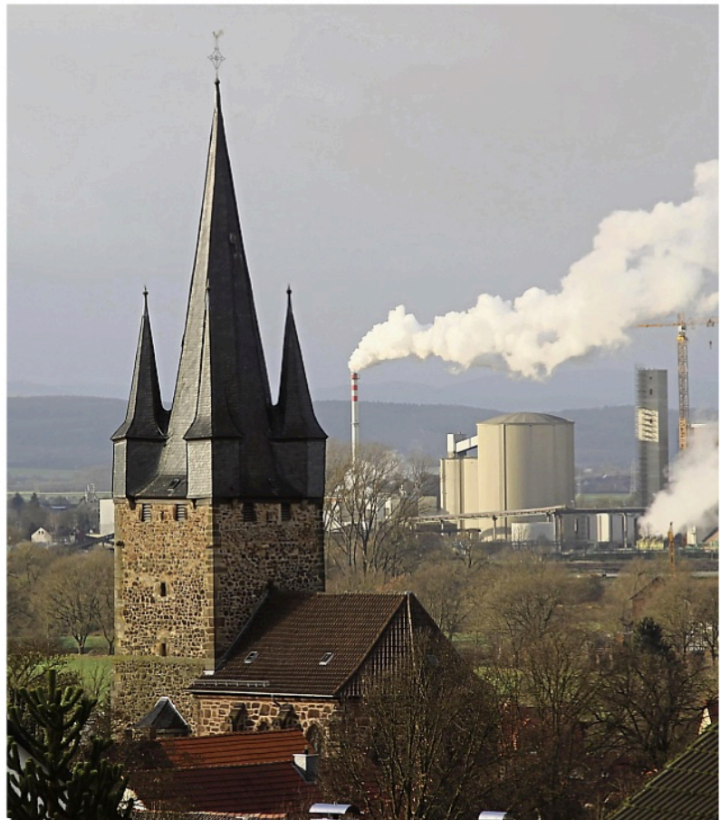
Blick über den Waberner Ortsteil Harle hinweg auf die Zuckerfabrik, eines der Wahrzeichen der Gemeinde. Derzeit wird eine neues Silo gebaut. FOTOS: MANFRED SCHAAKE/CLAUDIA BRANDAU
