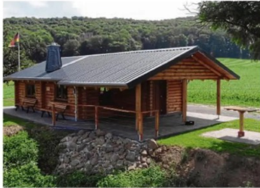
Die neue Küllbergshütte in Harle wird am Sonntag eröffnet. Das rechte Foto zeigt die verkohlten Balken der Küllbergshütte nach dem Brand im April 2019, durch die man auf die Waberner Zuckerfabrik blickt.
