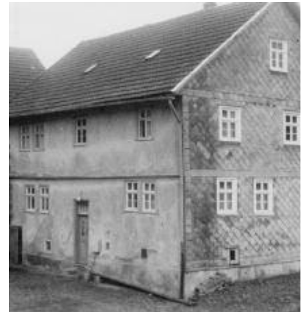
Das Haus 9 in den 1950er Jahren vor der Erneuerung.
