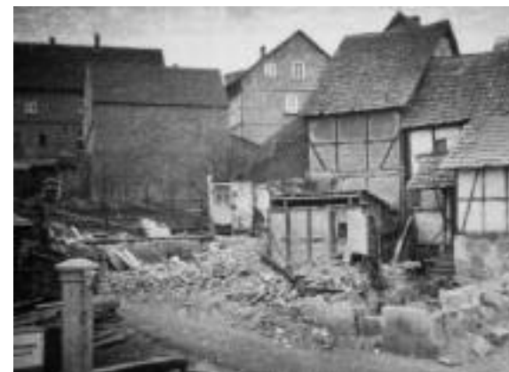
Nach dem Abbruch des Hauses 58 wird der Blick frei auf das Haus 57 ...
