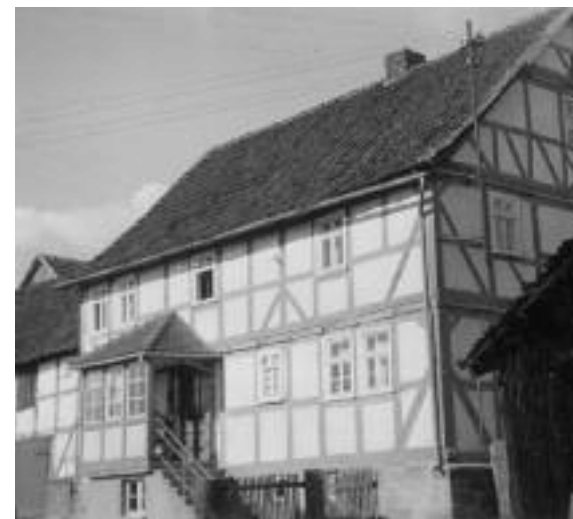
Das Wohnhaus, dahinter erstrecken sich die Werkstattgebäude.
