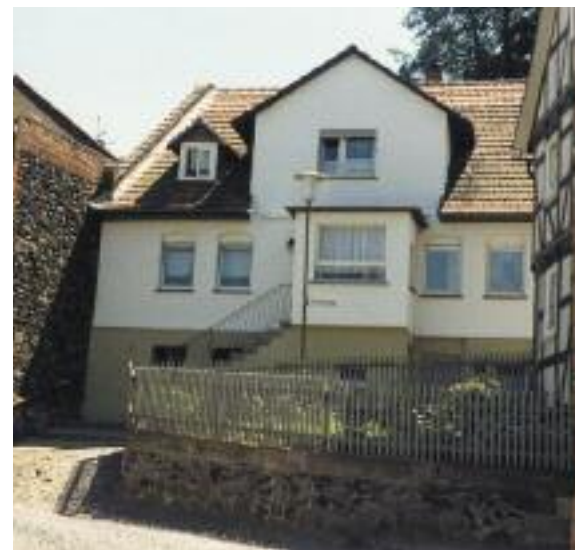
Das Haus 44 war ehemals ein altes Fachwerkhaus.
