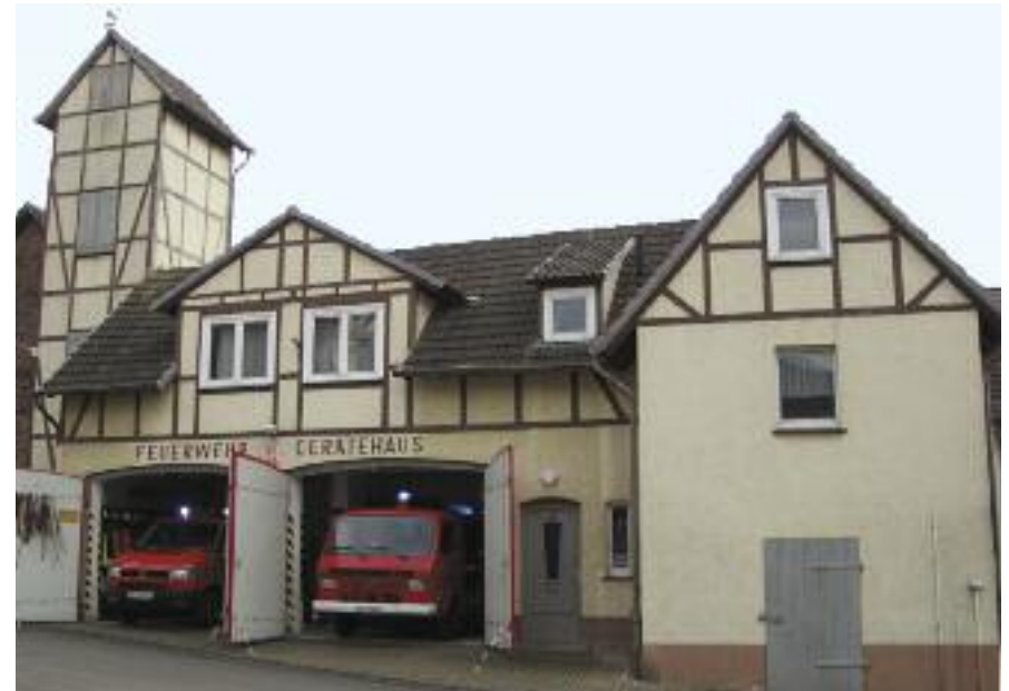
Die Fahrzeughalle der Freiwilligen Feuerwehr. Im Hintergrund ragt der Schlauchturm empor, er wird seit einigen Jahren nicht mehr genutzt. Der Backofen im rechten Gebäudeteil wurde im Frühjahr 2009 durch einen neuen ersetzt.
