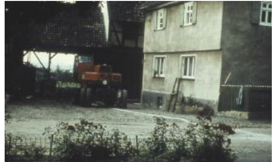
In mehreren Bauabschnitten hat Willi Gude in den 1970er Jahren das alte Haus in Massivbauweise erneuert. Auch die Stall- und Scheunengebäude wurden abgebrochen und das Grundstück neu geordnet.
