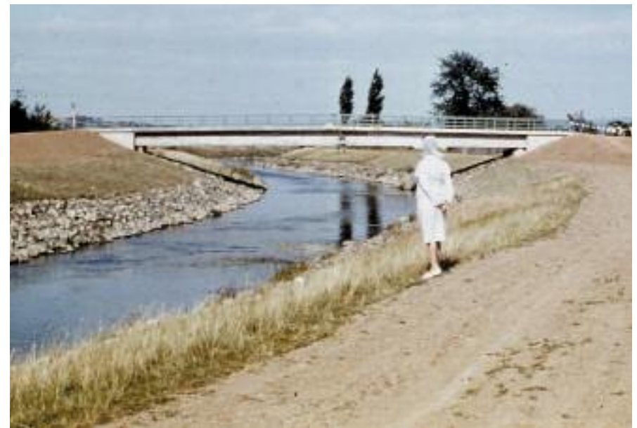
Die 1964 erbaute massive Brücke aus Stahlbeton über die Schwalm.
