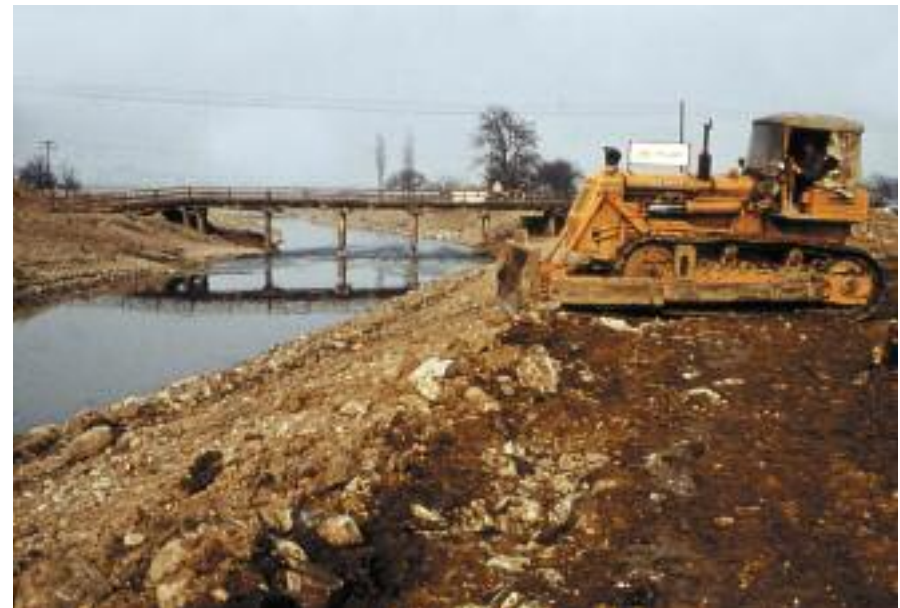
Beim Bau der beweglichen Stauklappe, an die sich die 300 Meter lange Flutmulde anschließt. Rechts: Das neue Schwalmprofil entsteht.
