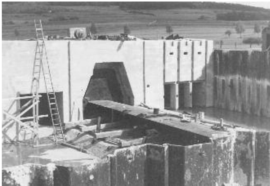
Beim Bau der beweglichen Stauklappe, an die sich die 300 Meter lange Flutmulde anschließt. Rechts: Das neue Schwalmprofil entsteht.
