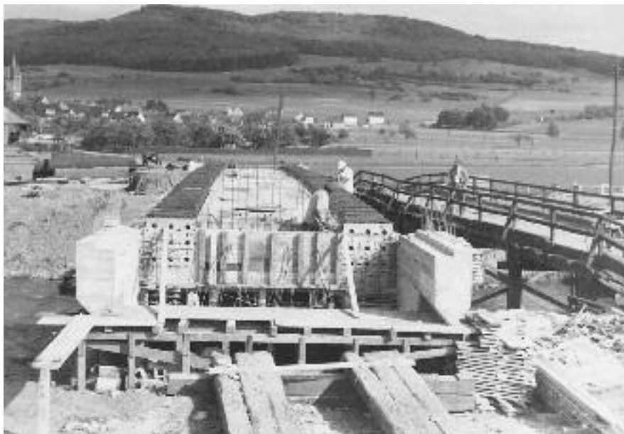
Während der Bauphase der neuen Brücke, daneben die alte Holzbrücke.
