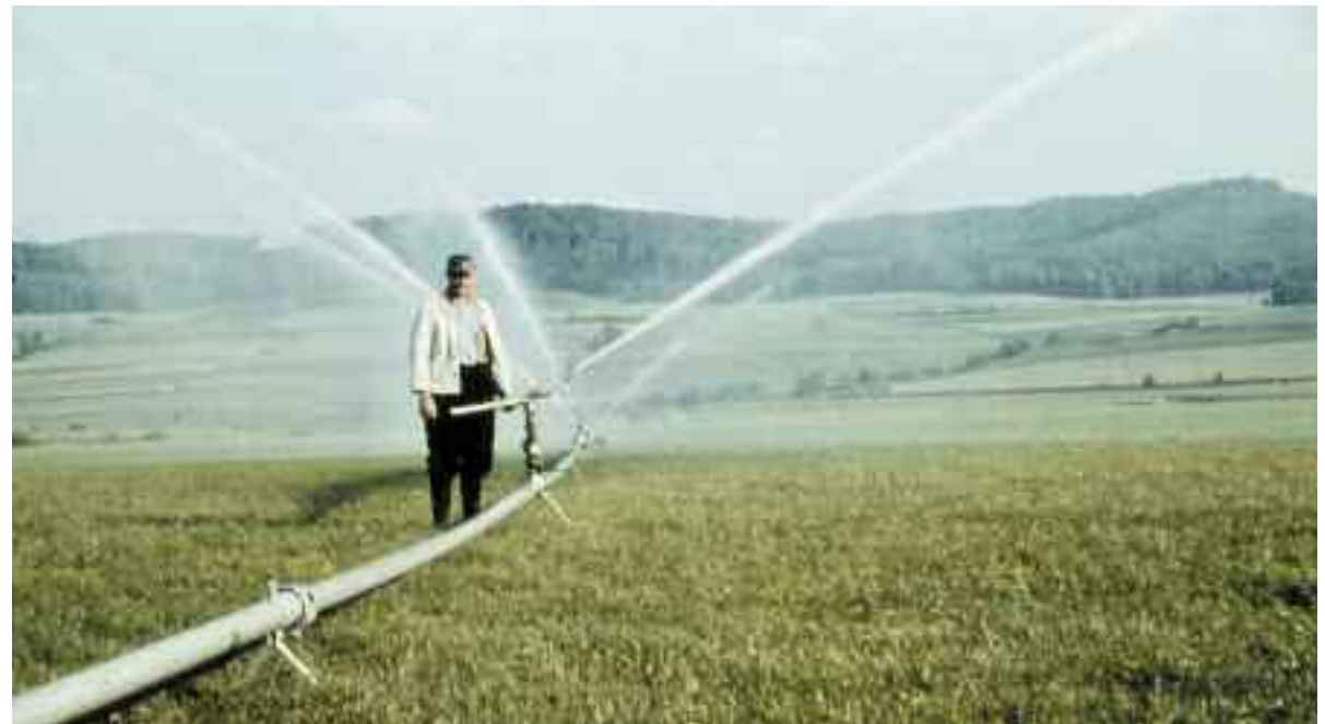
Otto Ast begutachtet den Aufbau der Rohrleitung.
